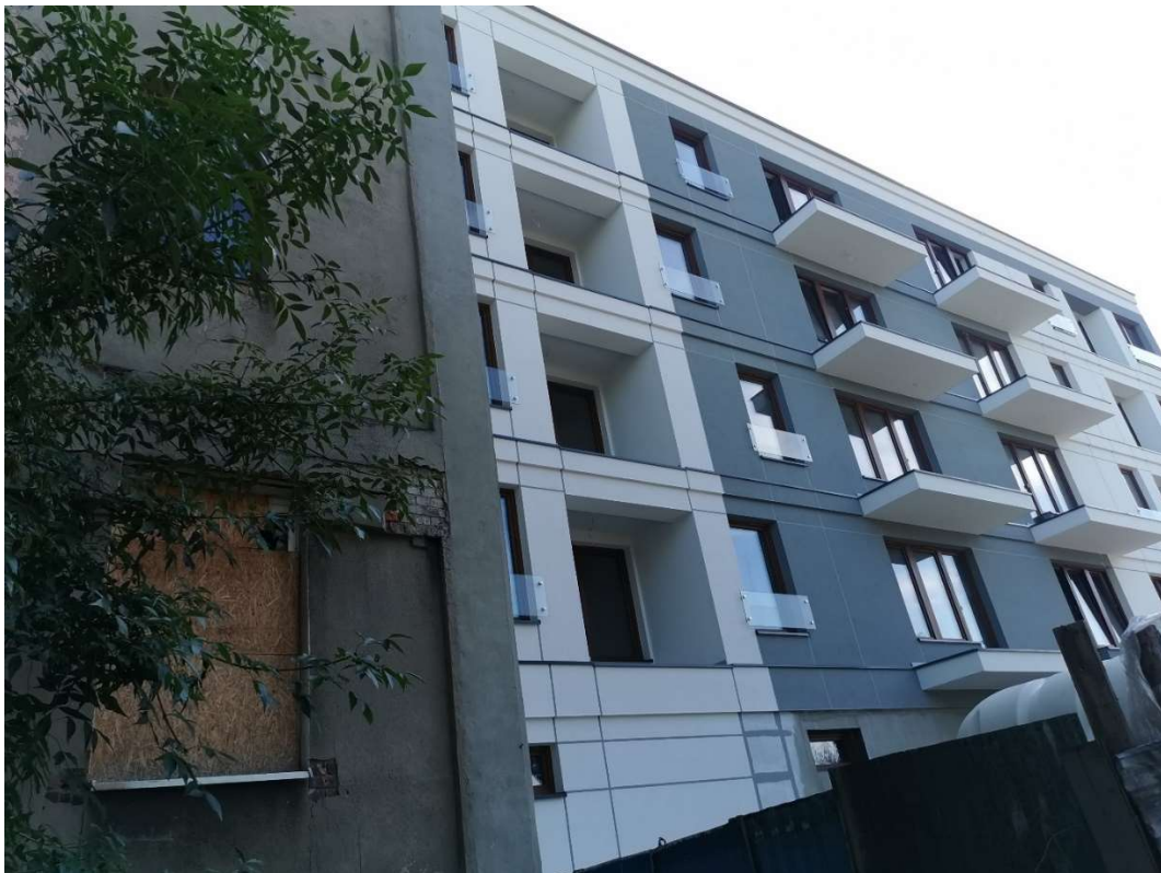
Fot. 14. Widok na elewację sąsiedniego budynku od strony ul. Ludwika Mierosławskiego
