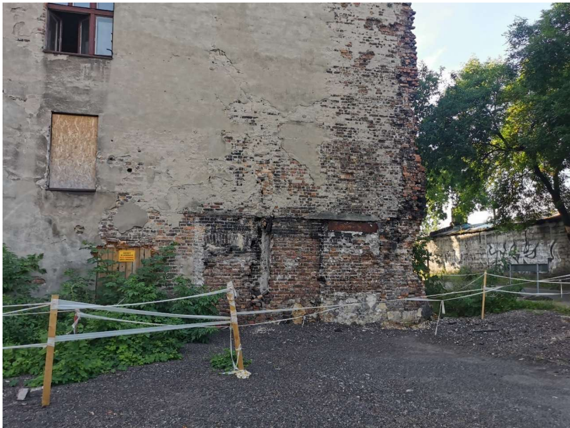
Fot. 9. Widok na elewację północno-zachodnią
