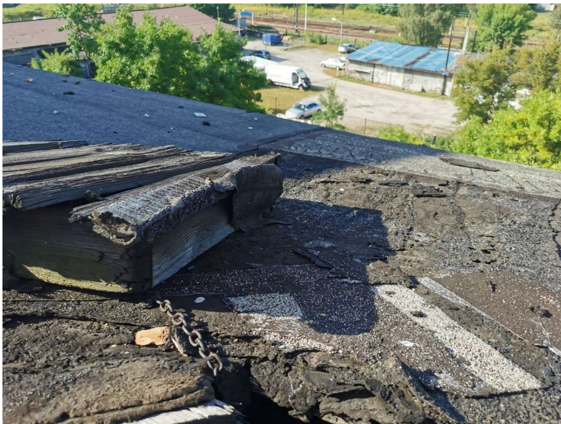
Fot. 20. Widok na południowo-zachodnią połąć dachową
