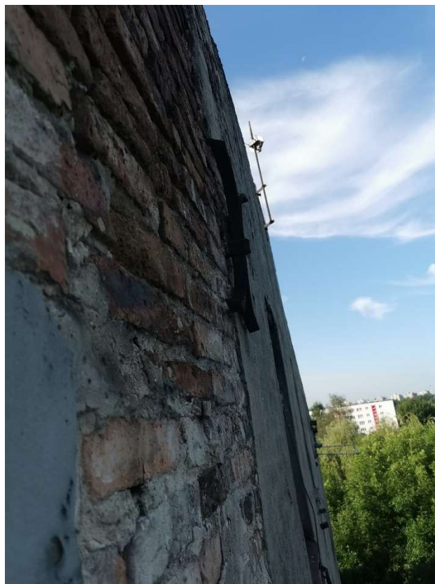
Fot. 36. Widoczne kotwienie na elewacji północno-zachodniej
