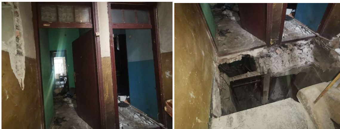
Fot. 27. Wejście do lokali mieszkalnych na pierwszym piętrze
