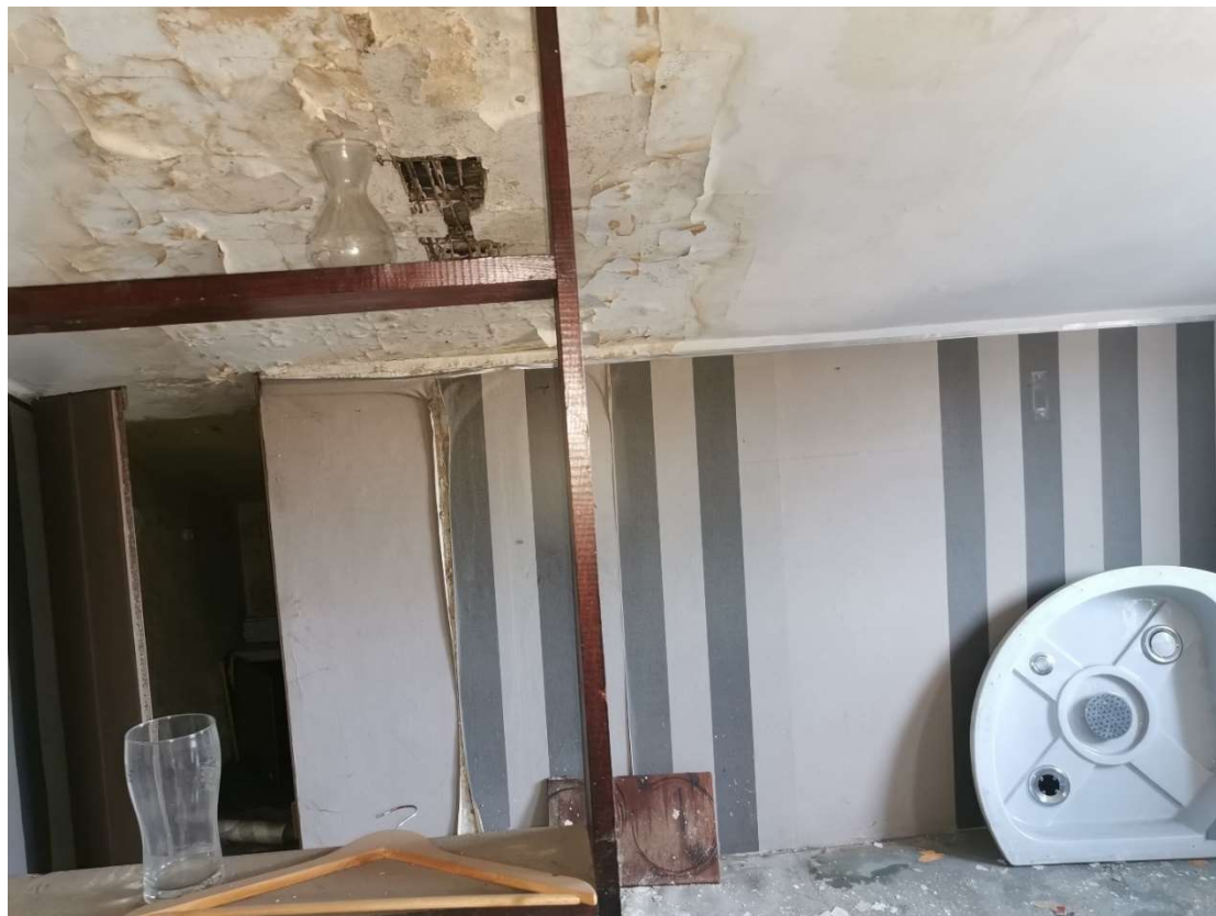
Fot. 38. Pomieszczenie mieszkalne na poddaszu
