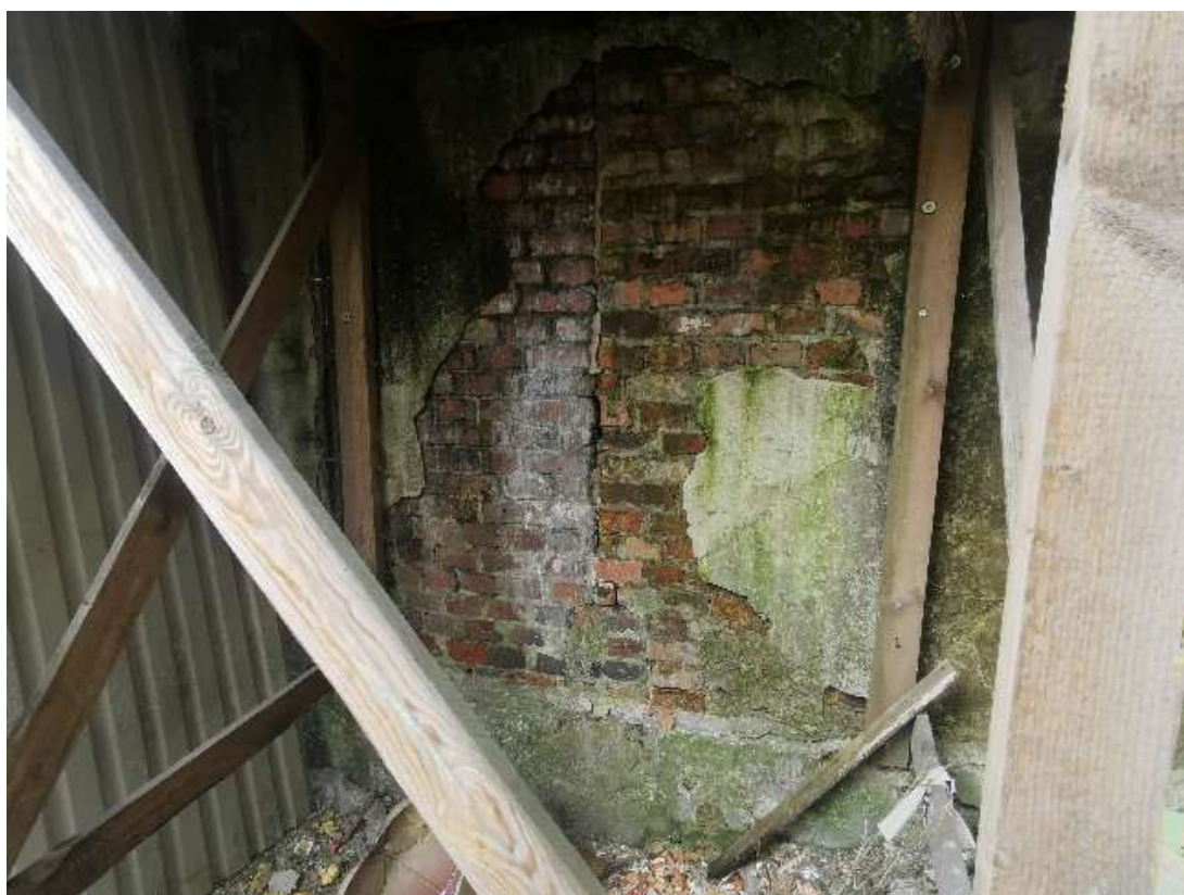
Fot. 7, 8. Widok na ścianę frontową od ul. Towarowej
