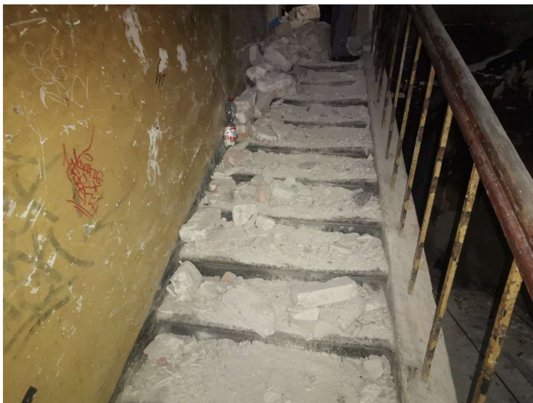
Fot. 23. Schody klatki schodowej prowadzące na kondygnację parteru
