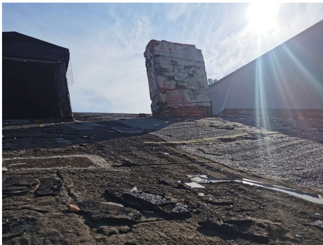
Fot. 21. Widok na lukarnę i komin na południowo-zachodniej połąci dachowej
