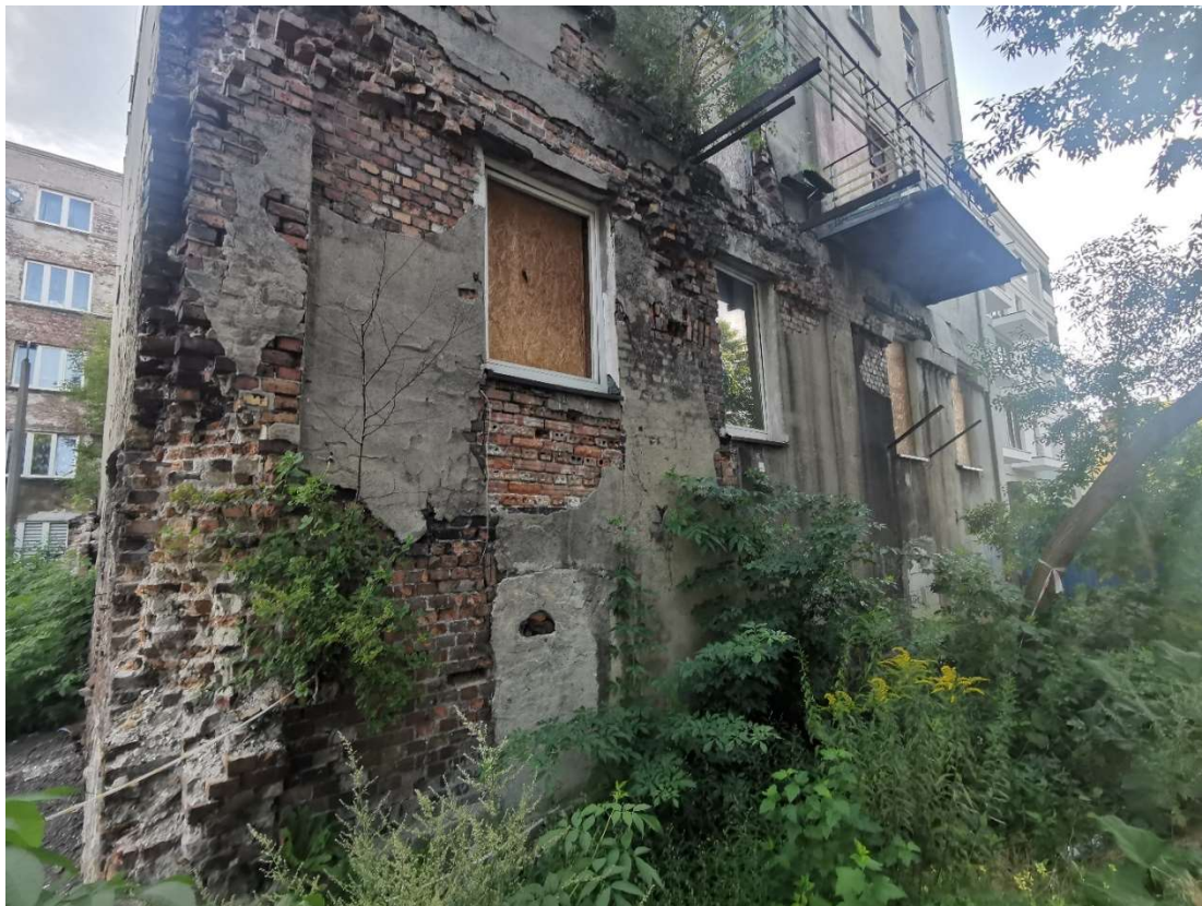
Fot. 11. Widok na elewację południowo-zachodnią
