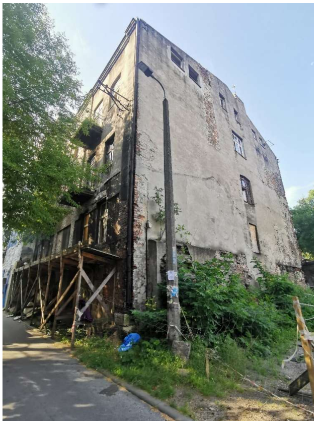
Fot. 1. Widok na naroże północno-wschodnie budynku
