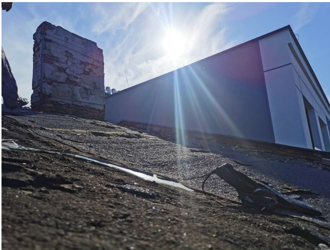
Fot. 22. Widok na ścianę szczytową sąsiedniego budynku
