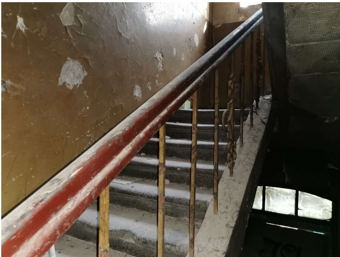
Fot. 39. Schody klatki schodowej
