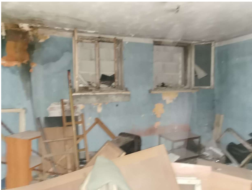
Fot. 33. Widok na pomieszczenie poddasza z widoczną ścianą sąsiedniego budynku
