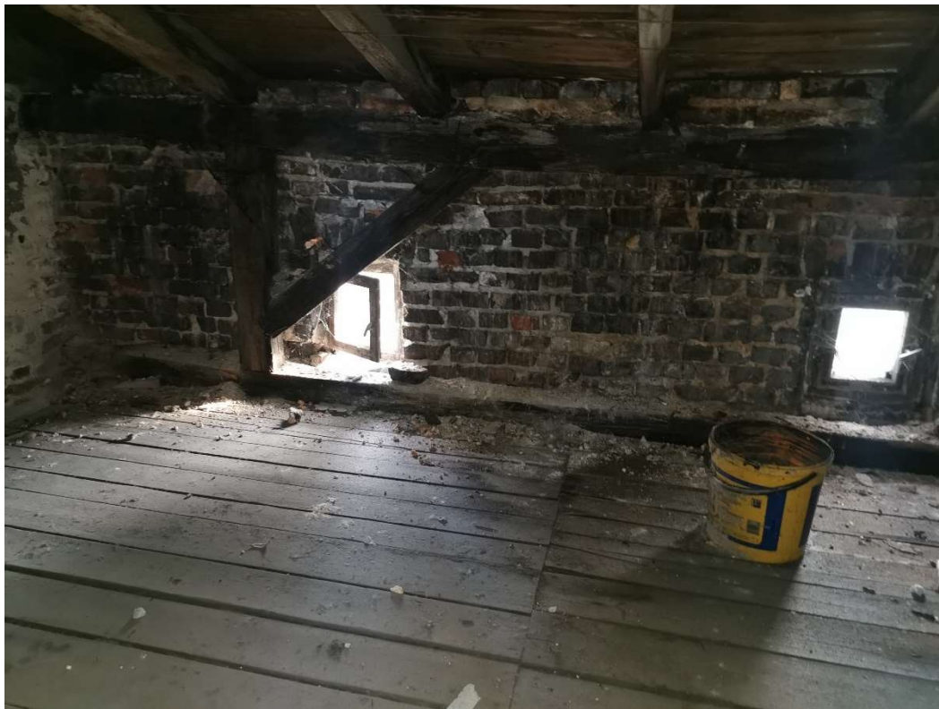
Fot. 35. Pomieszczenie nieużytkowe na poddaszu
