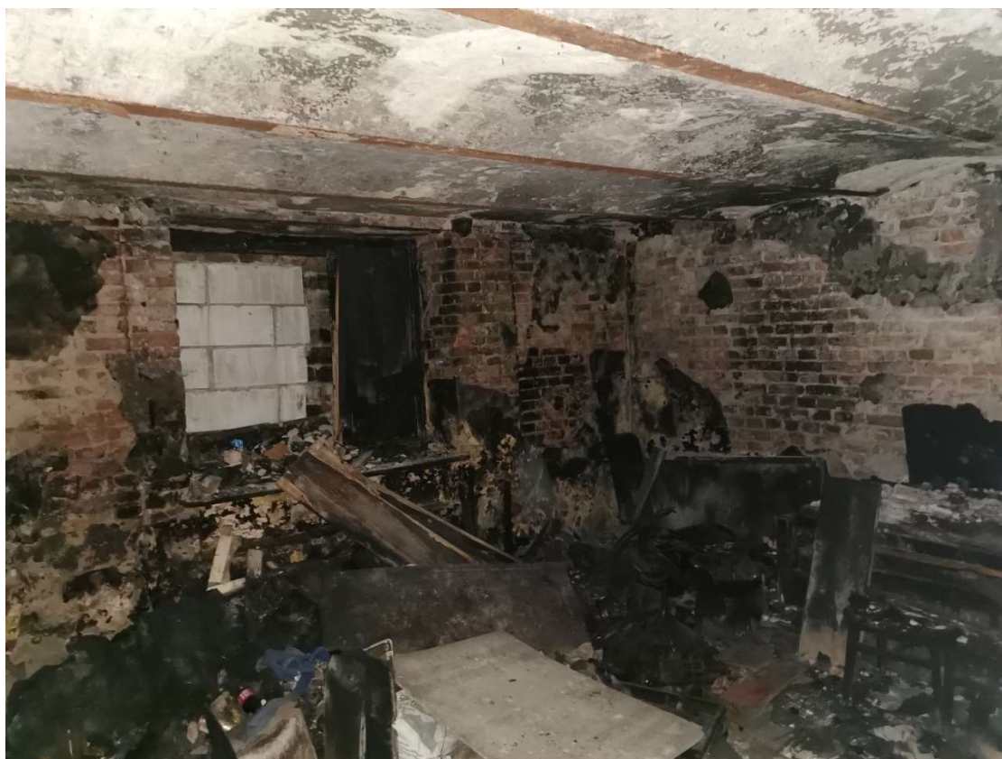
Fot. 40. Jedno z pomieszczeń piwnicznych
