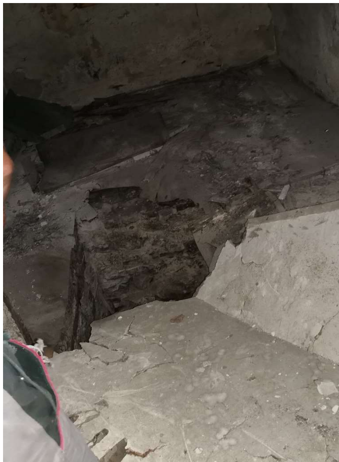
Fot. 42. Otwór w podłodze piwnicy
