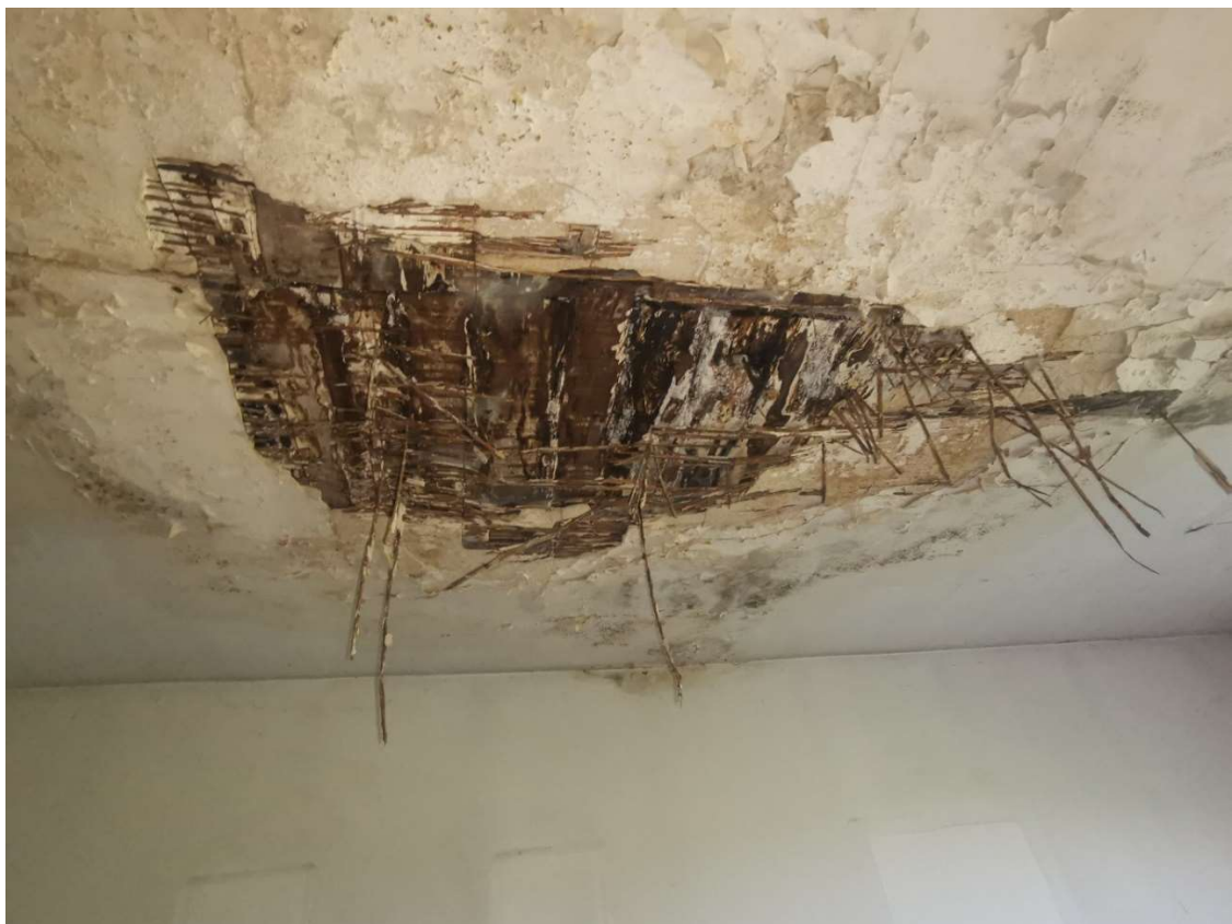
Fot. 32. Widok na strop pomiędzy poddaszem a drugim piętrem
