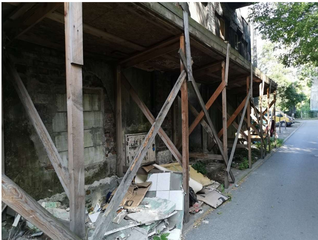
Fot. 16. Widok na zadaszenie ochronne od strony ul. Towarowej
