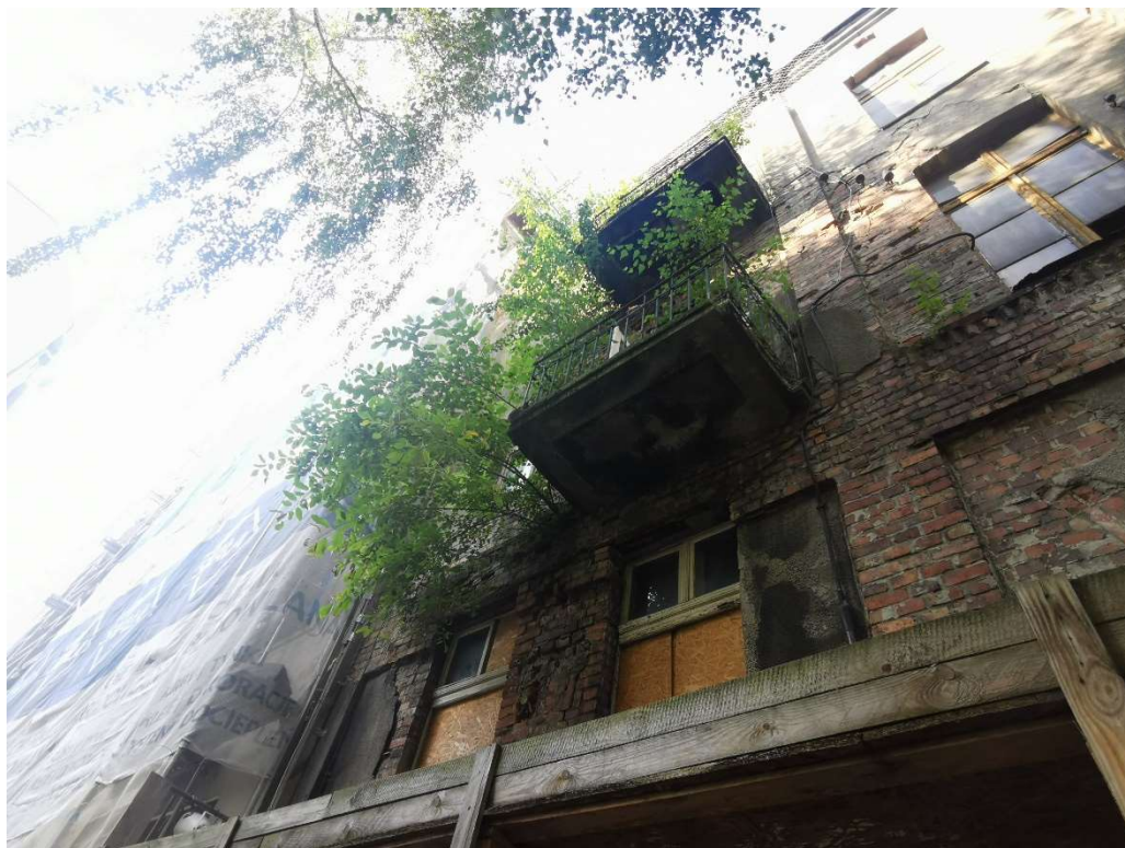
Fot. 3 Widok na ścianę północno-wschodnią
