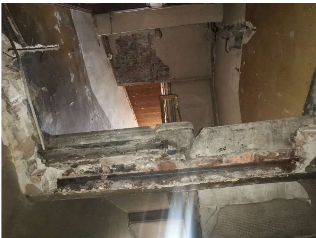
Fot. 25. Widok od dołu na klatkę schodową
