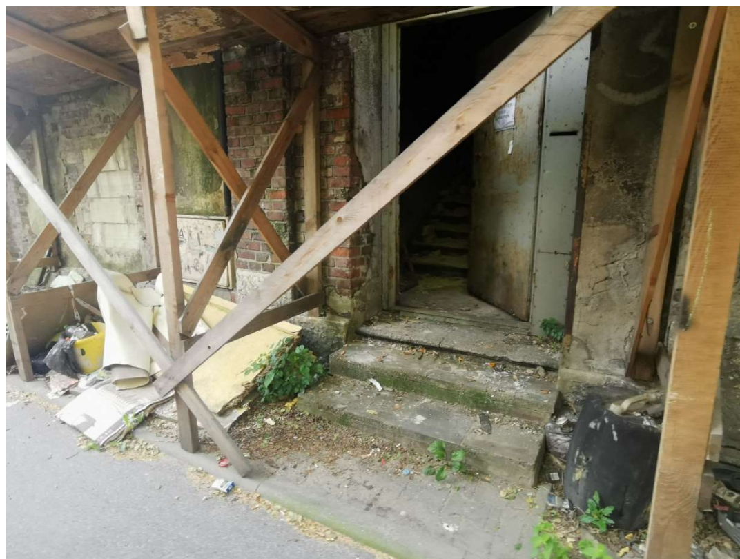
Fot. 6. Widok na drzwi wejściowe rozbieranego budynku od strony ul. Towarowej
