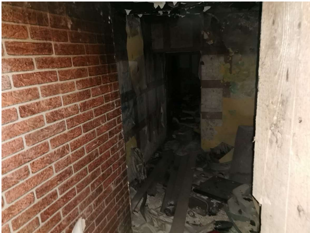
Fot. 41. Jedno z pomieszczeń piwnicznych
