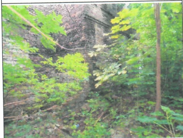
Fot. 05. Budynek mieszkalny – elewacja wschodnia nr 1
