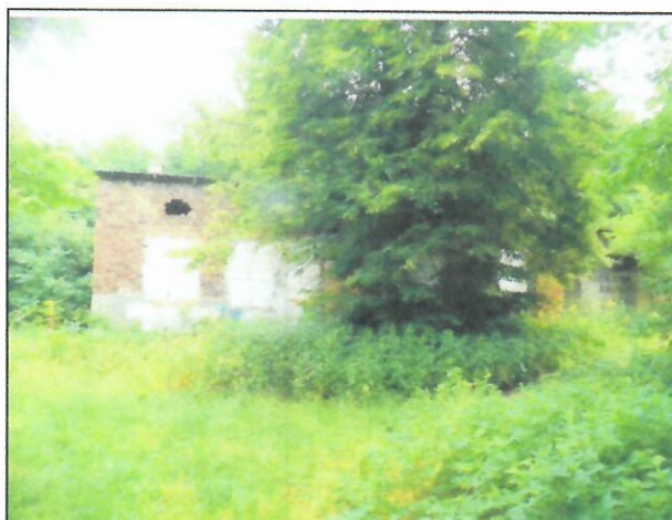
Fot. 10. Budynek gospodarczy – elewacja północna.
